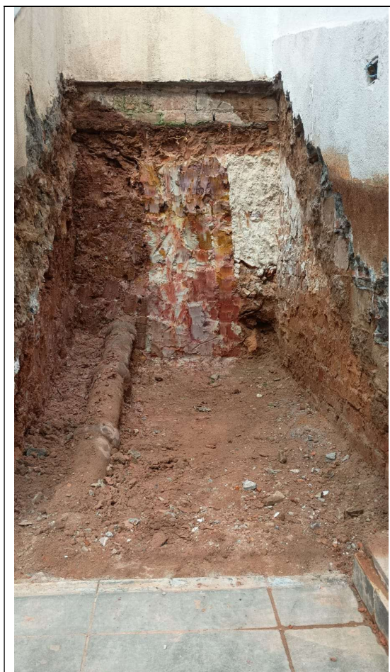
Foto da esquerda. Escavação do poço do elevador - vista frontal Foto à direita. Escavação do poço do elevador visto de cima.
