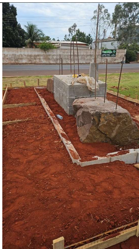
Base para a instalação do monumento 記念碑設置のための土台
